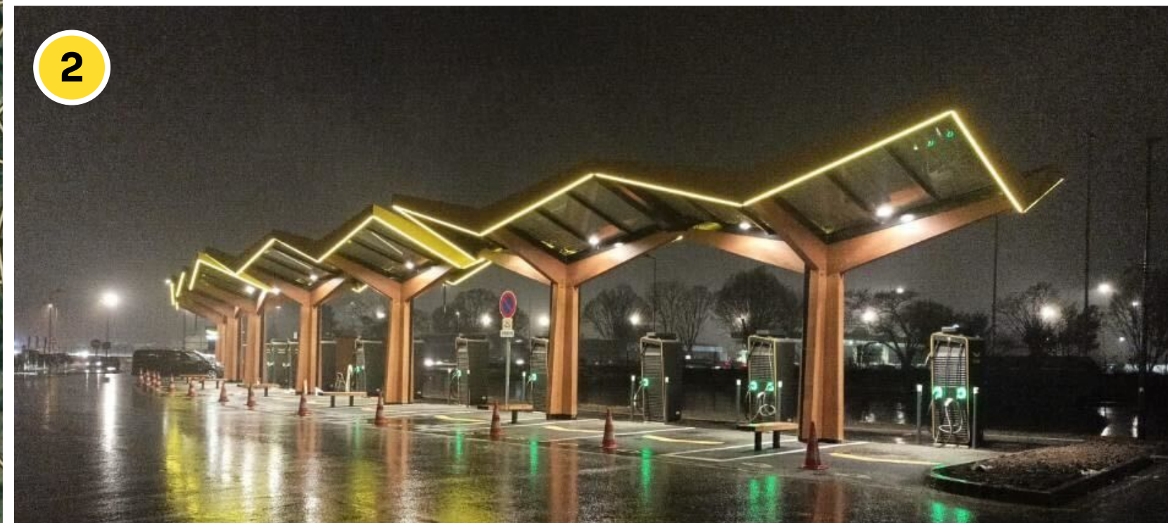
Aire de Vémars Est 16 x 300 kW chargers A1, France
